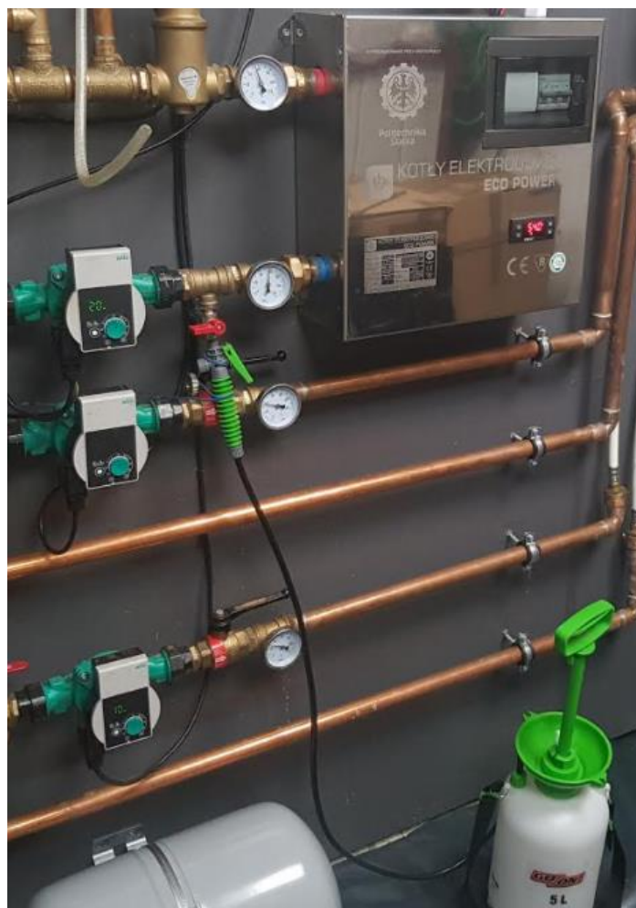
Rys. 6. Przykładowy sposób dodawania środka EP-FLUID (poprzez zawór 4 na rysunku 3).
